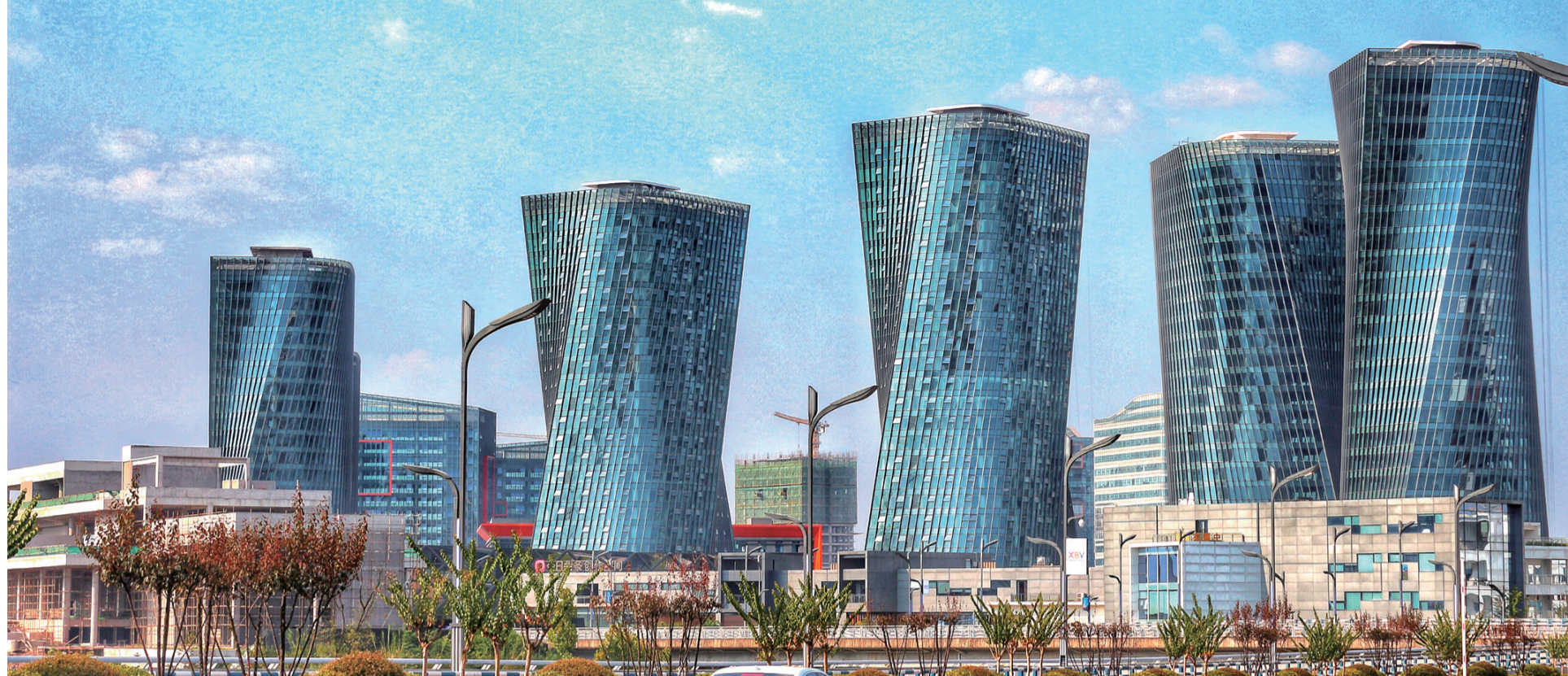
仙桃国际大数据谷中独特的“小蛮腰”建筑群
