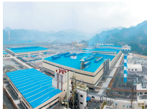
三磊玻纤全景图(工业园区)
