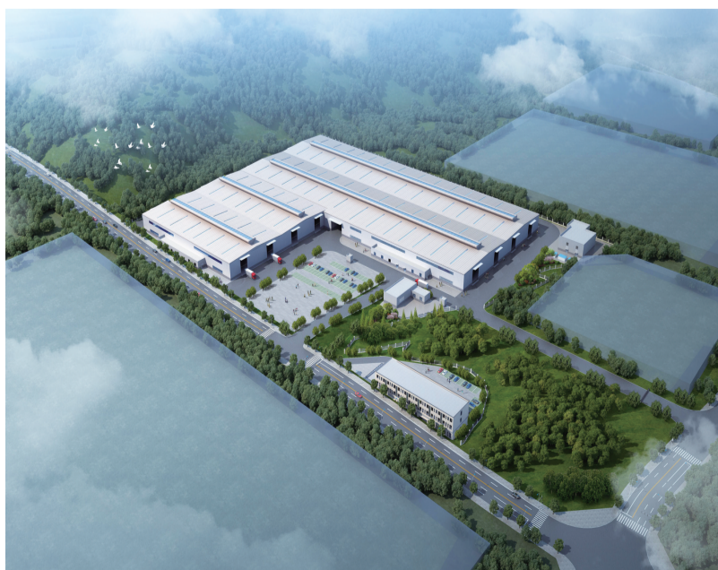
千信集团投资建设的重庆千信金属循环产业园(效果图)
