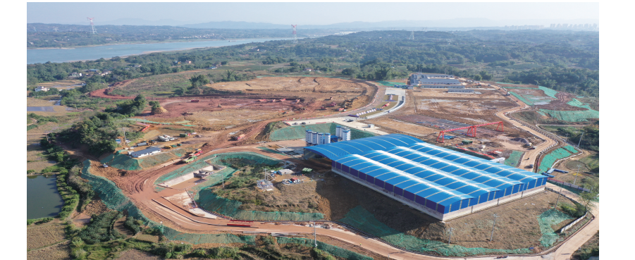
金刚沱泵站施工现场
