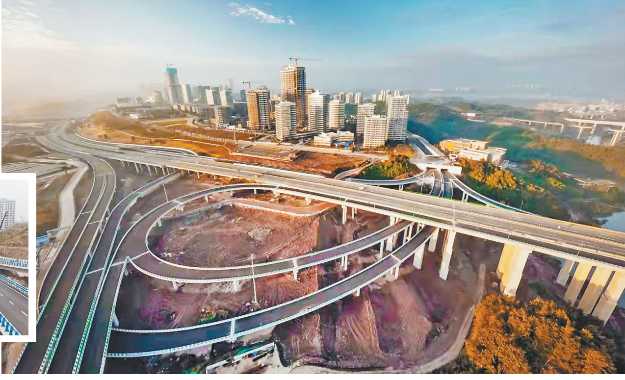
▲图为快速路二纵线华岩至跳磴段建设场景。（市住房城乡建委供图）
