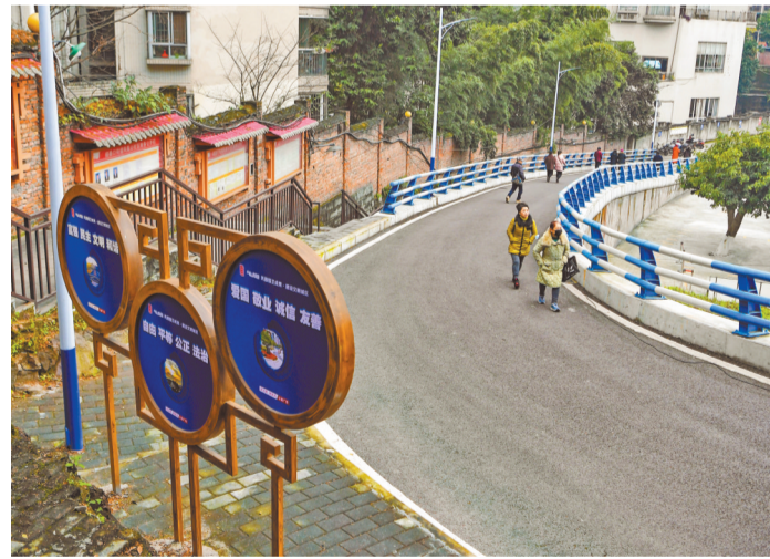
二〇二一年十二月二十九日,沙坪坝区凤嘴小区,昔日的岩壁经过改造,变身一条方便居民出行和车行的“安全路”。
