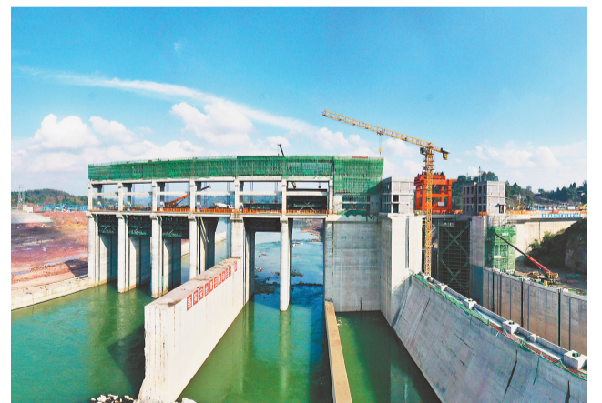
2021年12月13日，合川区钱塘镇米口村，工人对嘉陵江利泽航运水利枢纽工程船闸进行清淤和闸门调试收尾工作，为即将通航做准备。 特约摄影 钟志兵/视觉重庆
