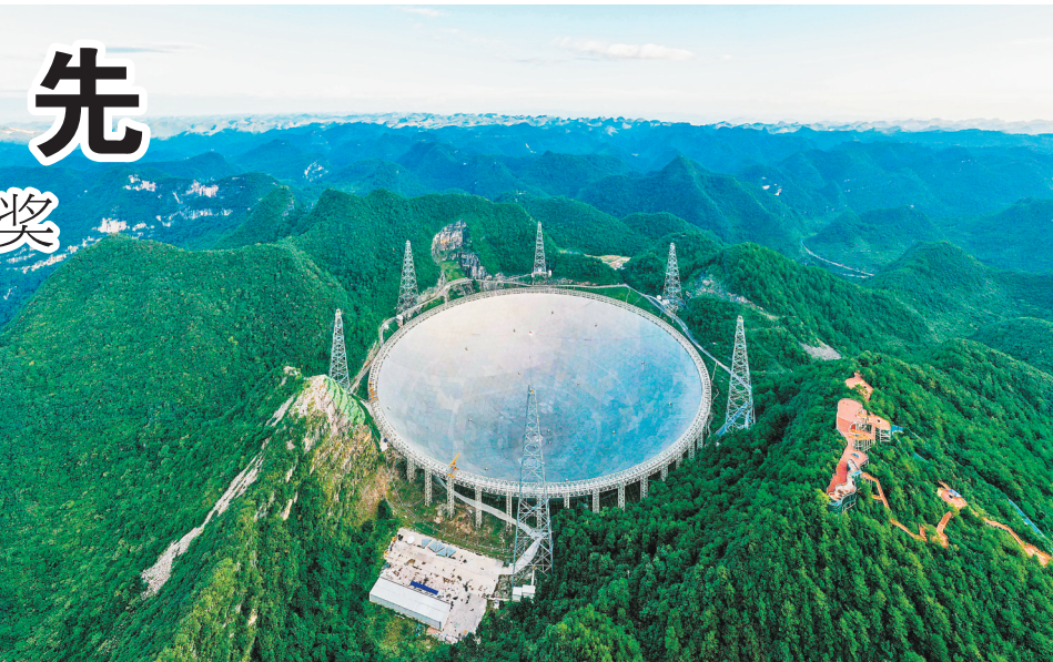
“中国天眼”全景(2019年8月27日摄,无人机照片)。
