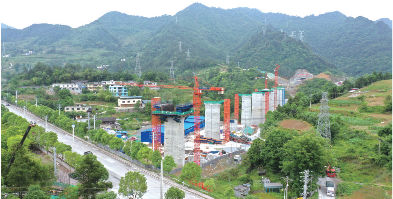
建设中的渝湘高铁黔江马家桥
