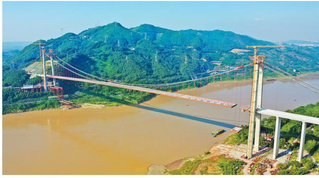
近日,合璧津高速公路江津油溪长江大桥最后一根钢箱梁顺利吊装,标志着大桥主体结构施工完成。 通讯员 苏盛宇 摄/视觉重庆
