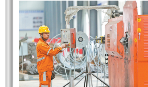
▲在城开高速项目部，建设工人正通过数控设备完成钢筋笼的下料、切割、制作，加工效率提高了3倍以上。
