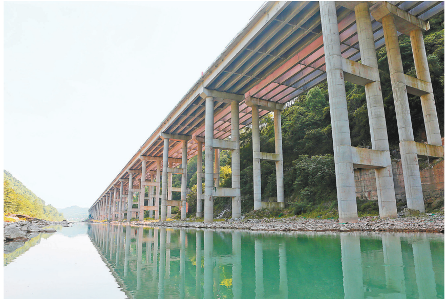
▲城开高速温泉特大桥在施工过程中，严格落实水土保持、弃渣综合利用等环保措施，打造绿色城开高速。
