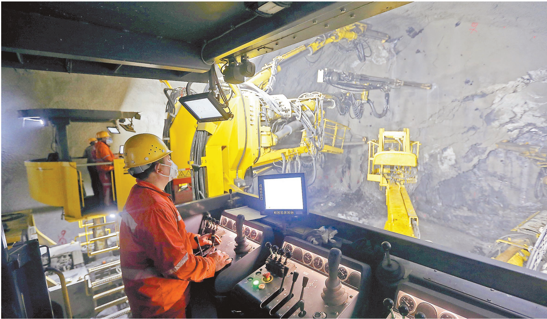
▲在城开高速公路城开隧道内，智能三臂凿岩台车犹如穿山甲一般，实现了高效安全的隧道掘进施工。
