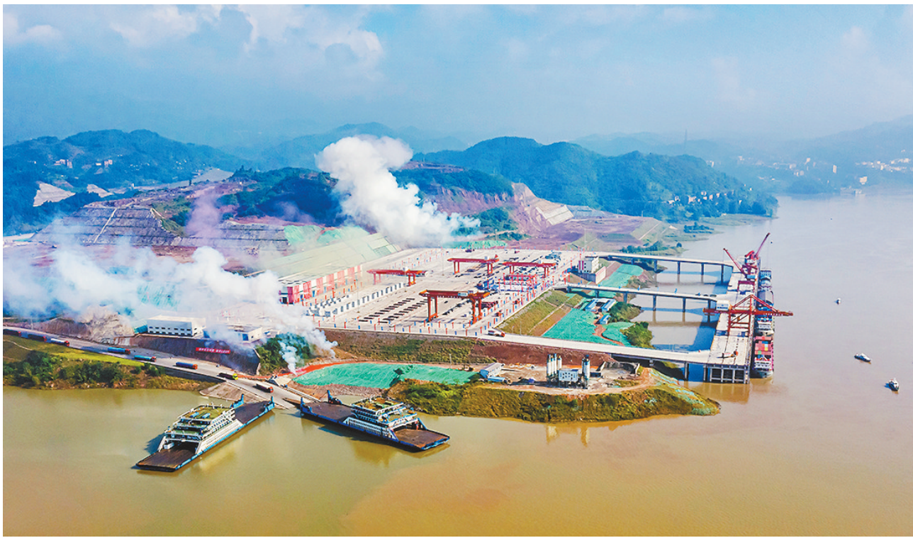
9月29日，位于忠县的重庆新生港正式开港运营。
