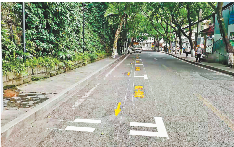
渝中区桂花园路新增设的临时停车位。(受访单位供图)
