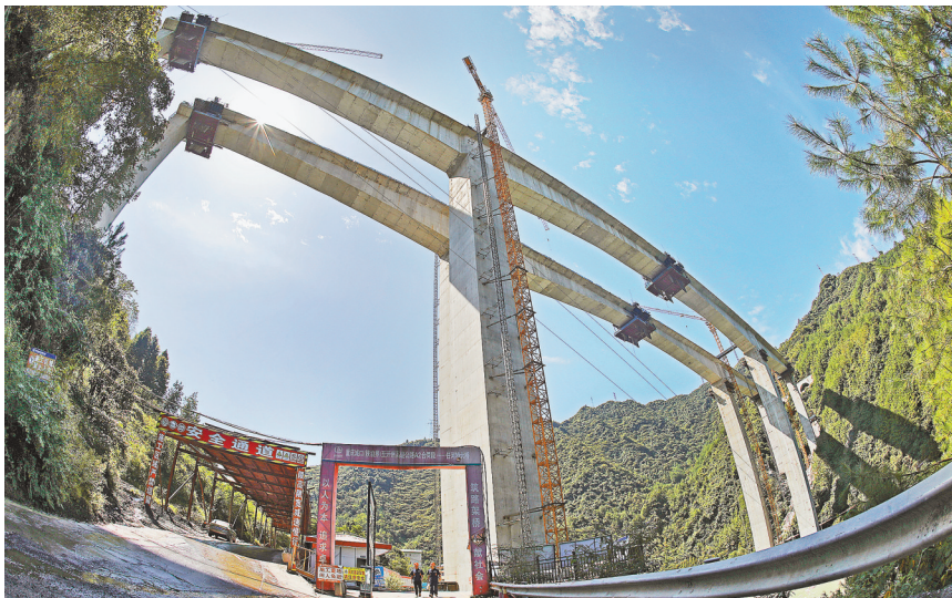
9月15日,城开高速控制性工程——任河特大桥正加紧施工。该桥单幅全长1264米,是城口县城第一座百米高墩特大桥,大桥有望本月底实现主桥合龙,为明年城开高速城口段通车奠定基础。
