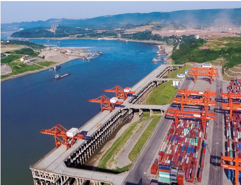
重庆农商行支持重庆港口建设。图为该行支持的重庆果园港一角
