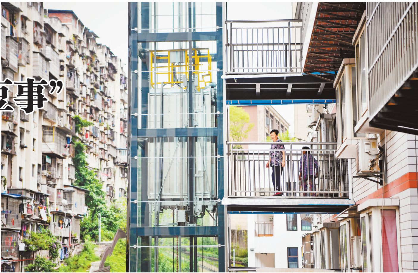
万州区钟鼓楼街道幸福社区丰收移民小区，老旧住宅增设电梯后，极大地方便了居民的出行。
