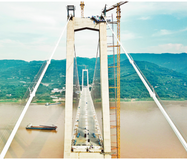
9月2日，万州新田长江大桥主体完工。大桥为主跨1020米单跨双铰钢箱梁悬索桥，全长1770米。据了解，大桥预计在2022年9月建成通车，届时万州80公里城市环线高速公路将实现闭合。记者 谢智强 摄/视觉重庆
