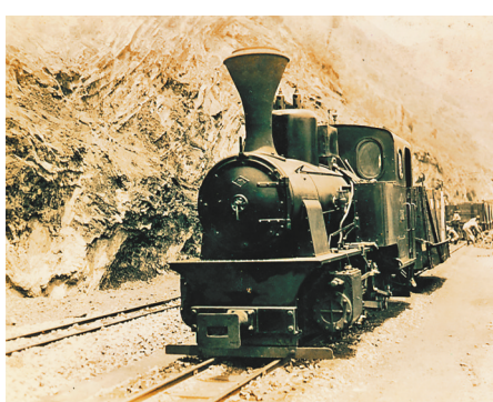
当年四川境内修建的第一条铁路,时隔53年复建后即将投入使用
