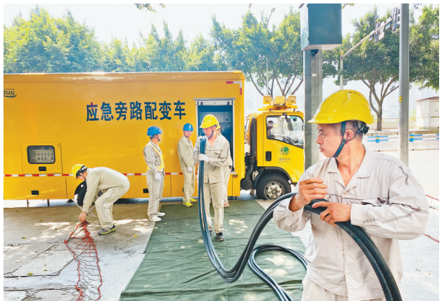
7月26日,国网重庆市区供电公司专业技术人员在渝中区江枫雅筑小区进行不停电检修。 记者 崔曜 摄/视觉重庆
