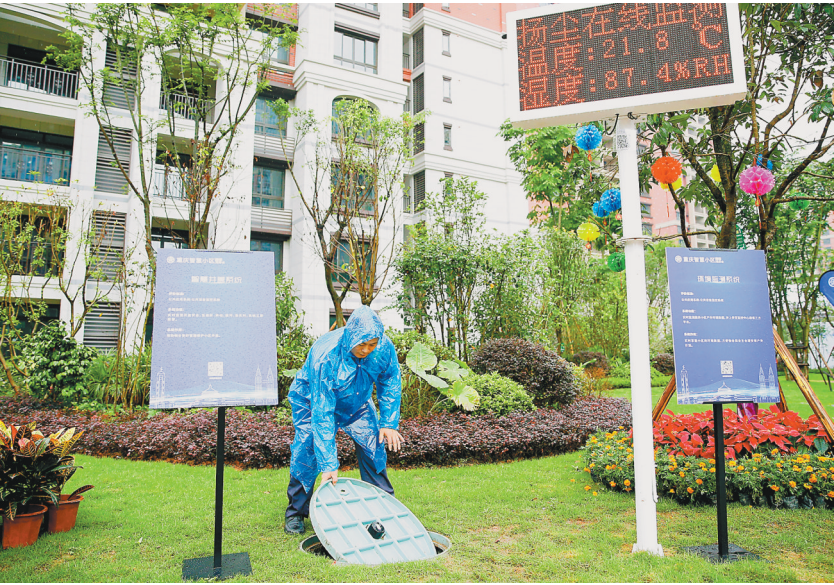
合川区漆金香榭小区，工作人员在展示智能井盖：当井盖倾斜、损坏或丢失时，系统会自动报警。（本报资料图片） 记者 崔力 摄/视觉重庆
