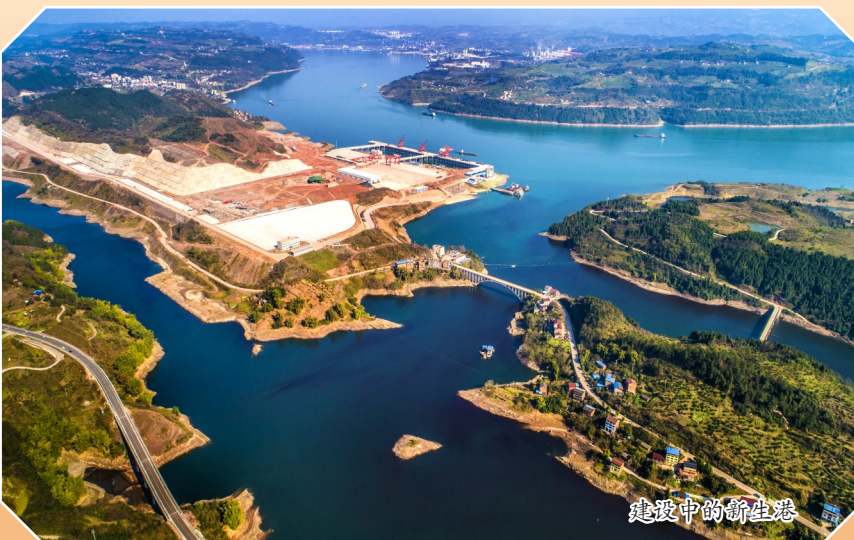
建设中的佛照寺
