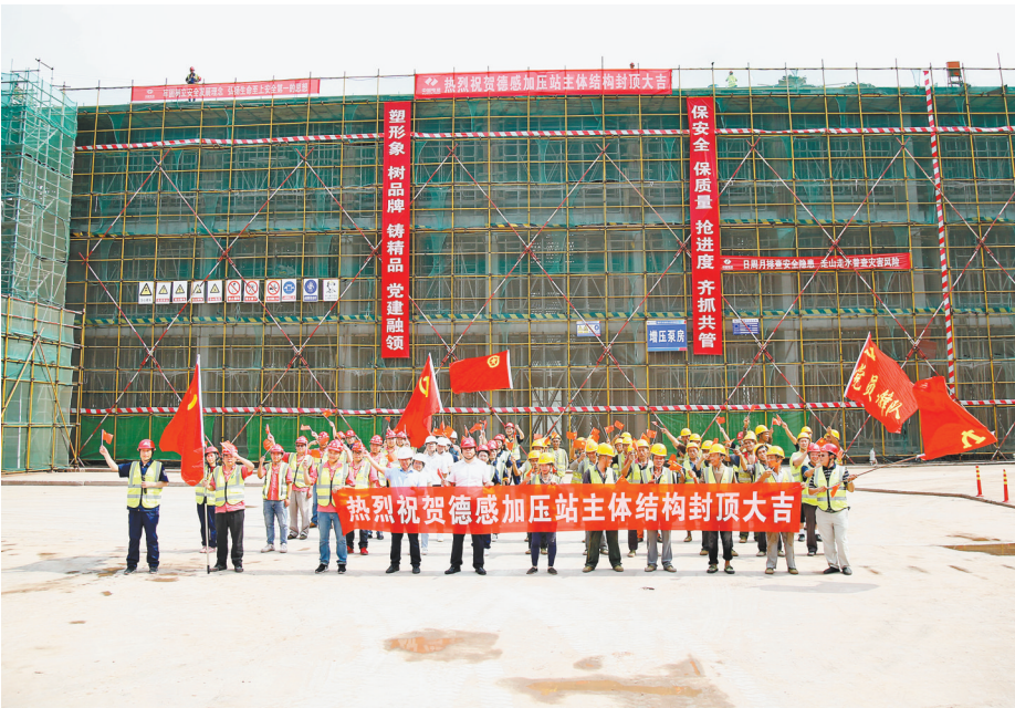
德感加压泵站主体工程封顶。（市水利局供图）
