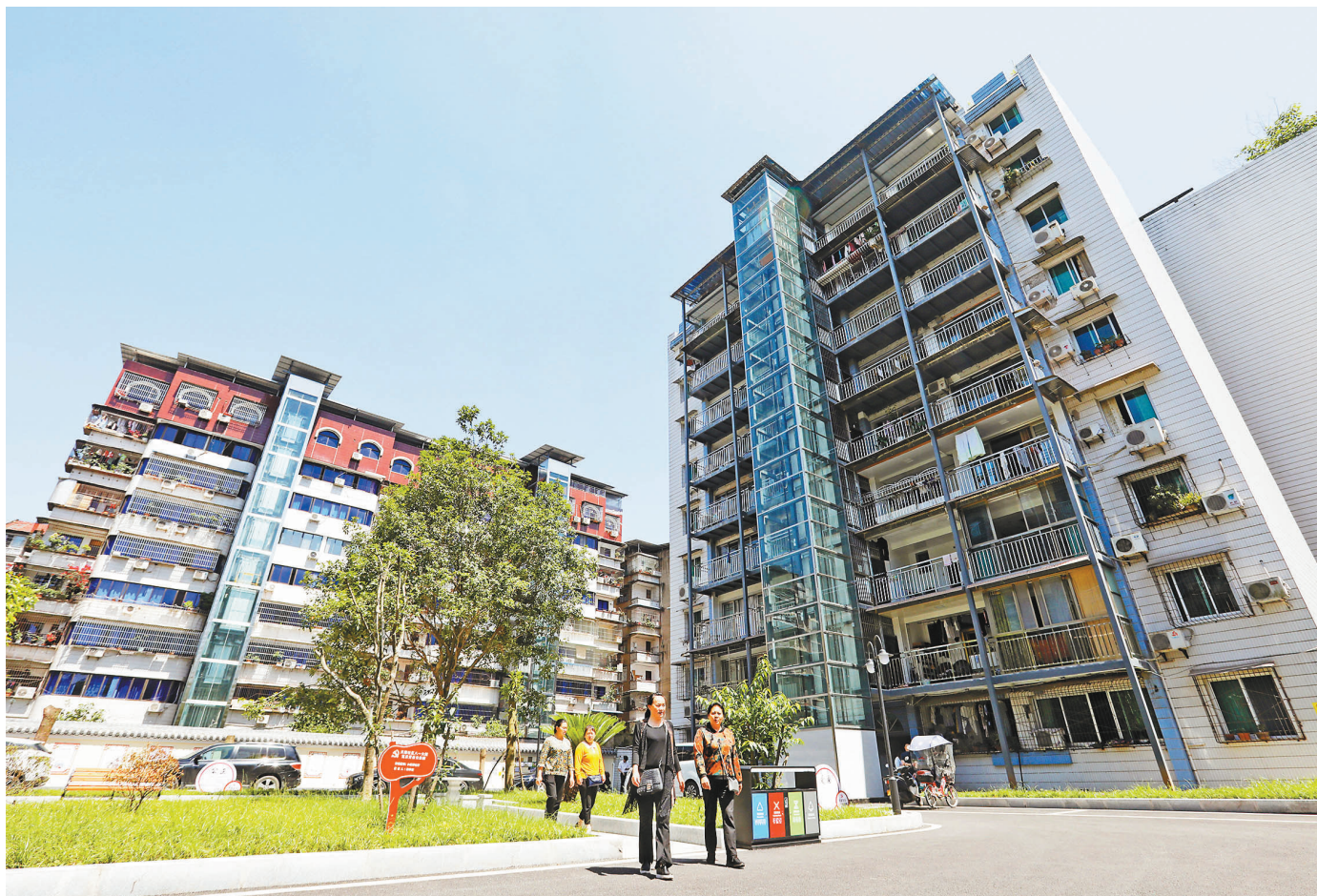
▲垫江桂阳街道地稅八一大院,小区加装电梯后极大方便了居民出行,一些搬出去的住户又回来了(摄于2021年6月4日)。记者 罗斌 摄/视觉重庆
