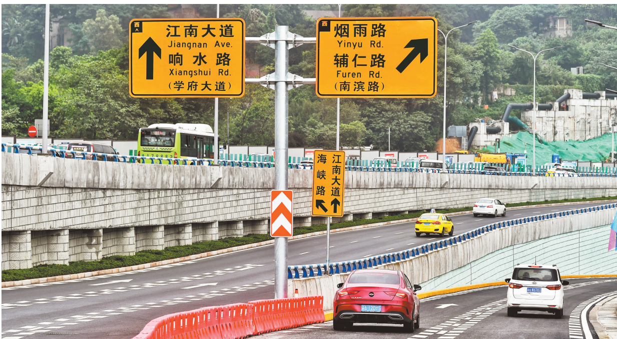
六月二十八日，南岸区江南立交内环下行方向至烟雨路口匝道建成通车。记者 谢智强 通讯员 郭旭 摄影 视觉重庆
