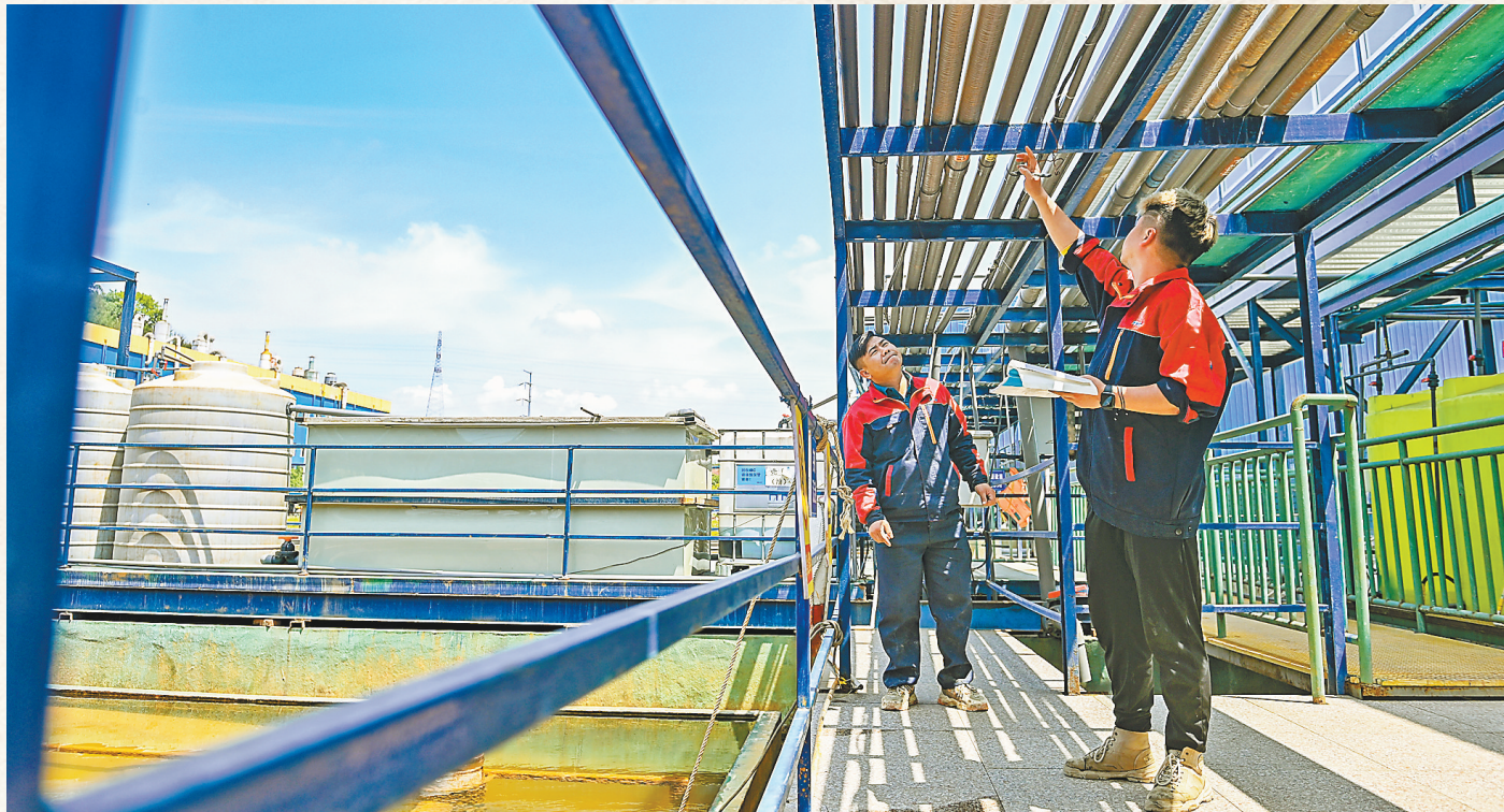
大足双桥经开区,工作人员正在检查污水管网是否有破损情况。(本报资料图片,摄于四月二十七日) 首席记者 龙帆 摄
