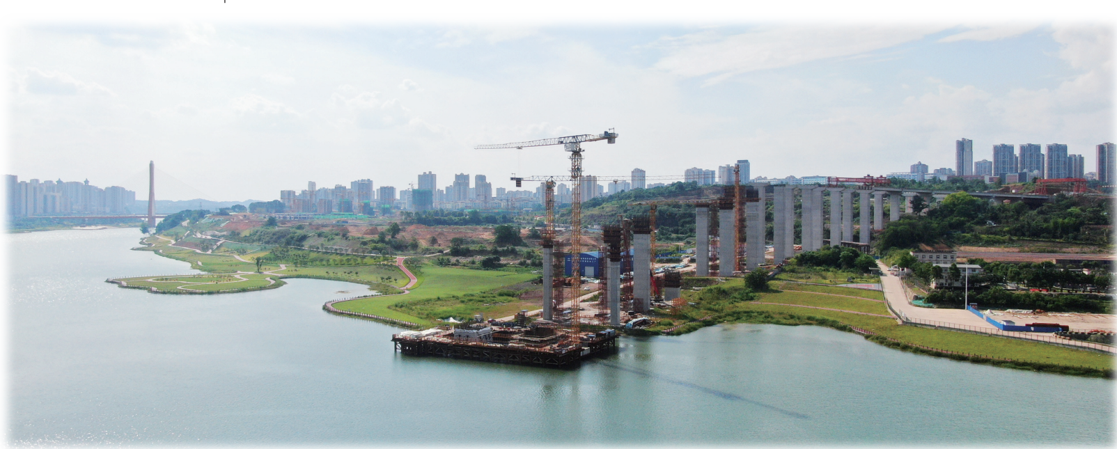
市级重点工程——位于潼南区城市复合中心的东升大桥施工现场 摄/杨筱萼、周胜芳
