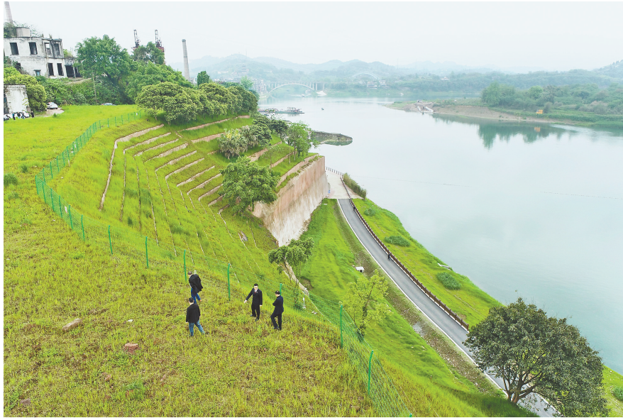
铜梁区安居镇涪江边，治理后的红蝶锑业渣场，铜梁区检察院工作人员在此检查恢复情况（摄于四月十四日）
