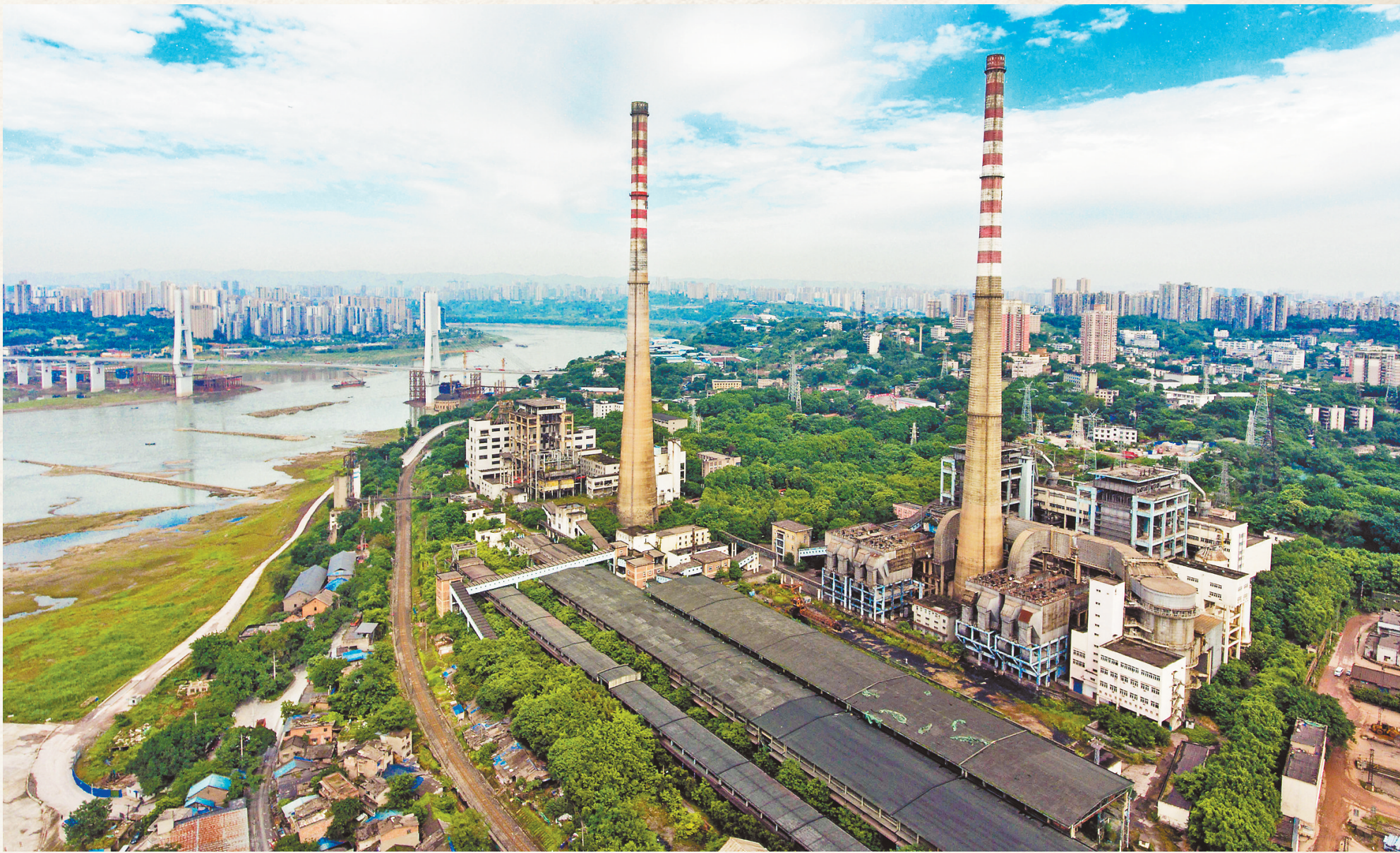
六月四日,九龙坡区黄桷坪的重庆发电厂老厂区内,两根二百四十米高的烟囱屹立于此。 记者 张锦辉 摄/视觉重庆
