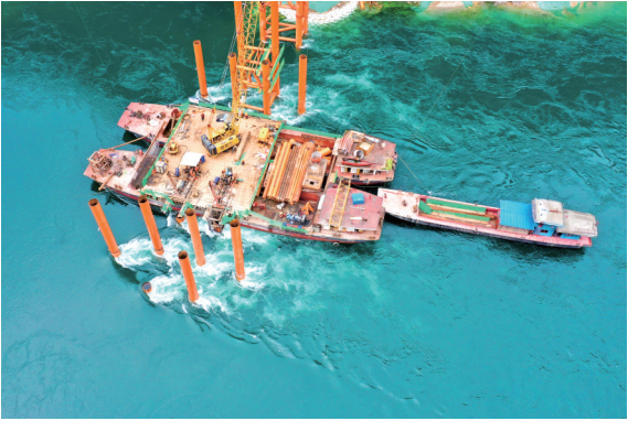
渝湘复线高速公路路磨寨乌江大桥建设现场
