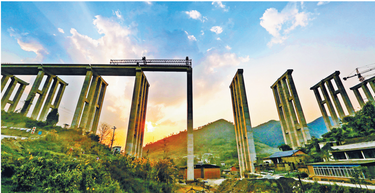
二月二十四日,渝黔高速公路扩能项目(万盛段)温塘村特大桥施工现场,架桥机进行预制T梁架设工作。 通讯员 王泸州 摄/视觉重庆
