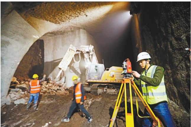
2月18日,重庆轨道十八号线歌台子站进行换乘站台开挖施工。 记者 罗斌 摄/视觉重庆
