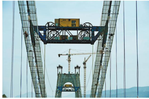
2月18日,巫山桂花大桥的建设者正在进行钢箱梁吊装。巫山桂花大桥位于长江支流大宁河上,属三峡移民后续工作规划重点交通建设项目,是连接巫山高铁站、巫山县城和巫山机场的重要通道。大桥全长1540米,主桥为主跨550米的双塔钢箱梁悬索桥,双向四车道,预计今年10月竣工。
