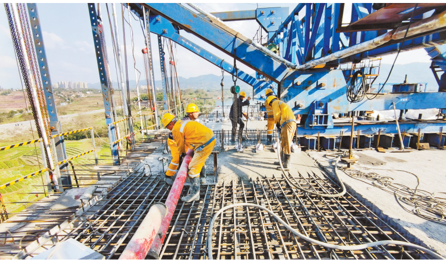
施工中的合长高速龙溪嘉陵江特大桥。（合长高速一标项目部供图）
