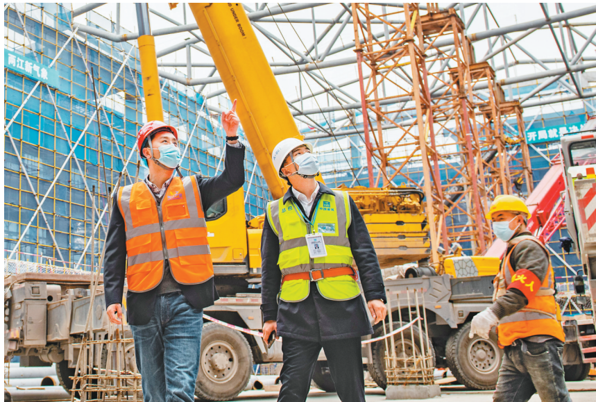
2月18日，在礼嘉智慧公园智慧馆项目工地上，两江产业集团礼嘉工程中心主任赵斌(左)正在检查智慧馆屋顶安装推进情况。春节期间，智慧馆建设加班加点，确保了项目进度。整个项目预计今年7月底完工。 记者 张锦辉 摄/视觉重庆
