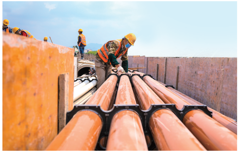
龙溪河流域城镇雨污分流工程施工现场 摄/熊伟
