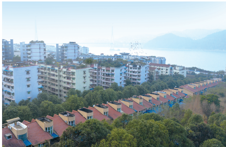
建设组团老旧小区改造 摄/陈健
