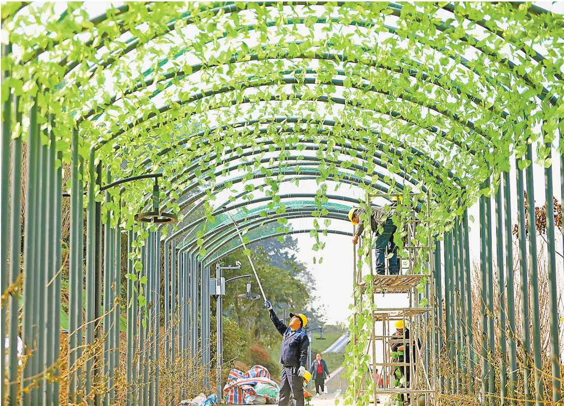
一月十四日，建设者正在半山崖线步道主线虎头岩—佛图关段进行最后的装饰清洗。
