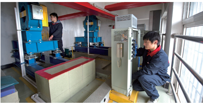
电梯工程维修人员正在对设备进行维护保养，南岸区“三无”老旧电梯提前超额完成改造，近千户居民受益 摄/梅琅
