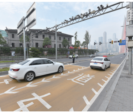
南岸上新街片区道路进行智能化交通改造
