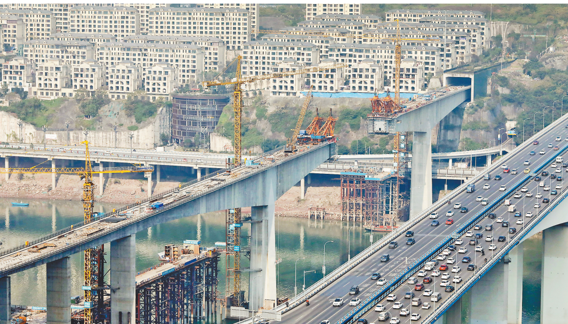
一月十九日，嘉华轨道专用桥正在施工中，预计本月合龙。该桥是轨道交通九号线一期工程唯一的跨江轨道专用桥。记者 罗斌 摄 视觉重庆
