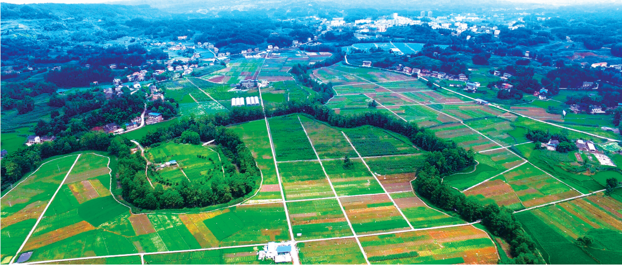
涪陵区龙潭镇新乐村土地整治项目土地平整初见成效
