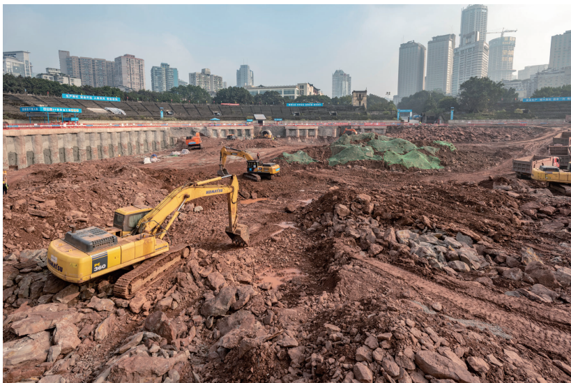
大田湾体育场保护与利用工程施工现场
