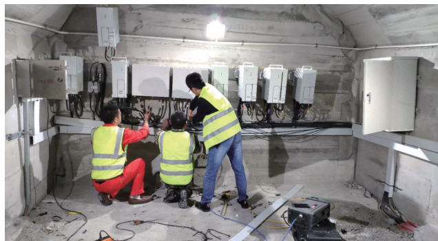
中国移动建设团队在成渝高铁隧道内进行网络建设
