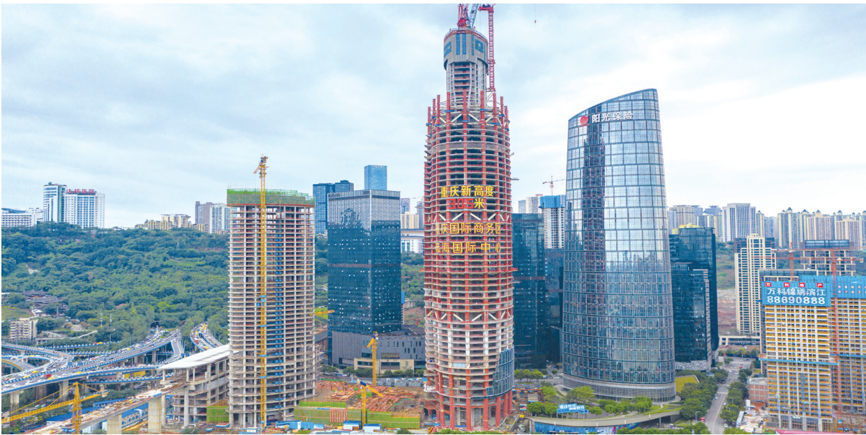
修建中的陆海国际中心
