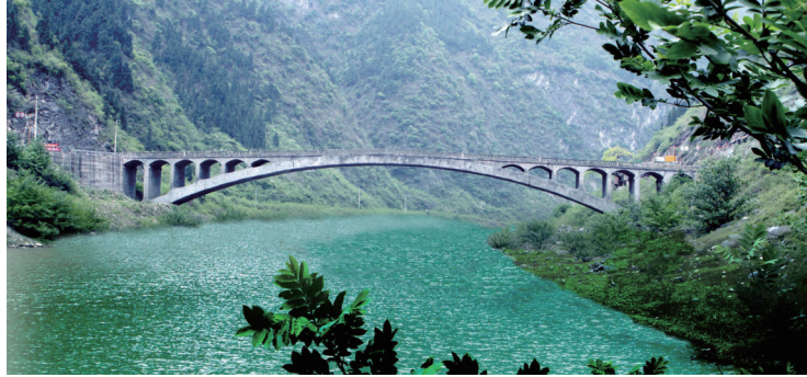
龙河国家湿地公园九溪沟大桥
