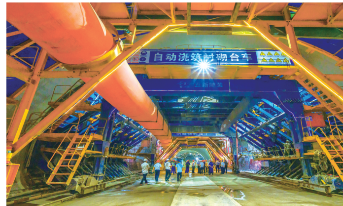
合璧津高速铜梁第一工段
