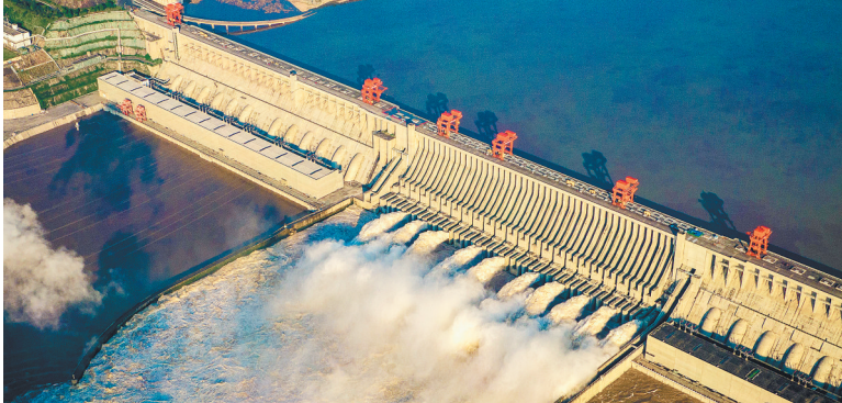
长江三峡水利枢纽工程开 启泄洪深孔泄洪(二〇二〇年八月 十九日摄,无人机照片)。 新华社记者 肖艺九 摄
