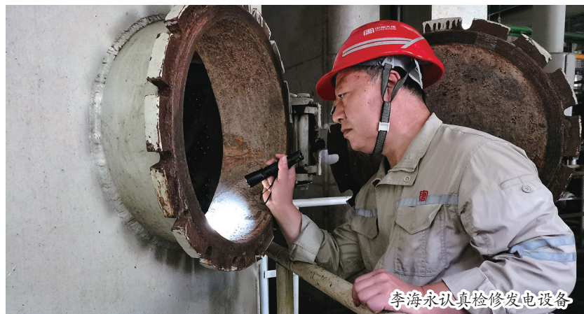
李海永认真检修发电设备
