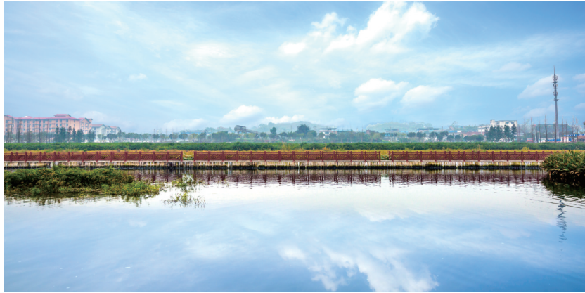
梁滩河整治后
