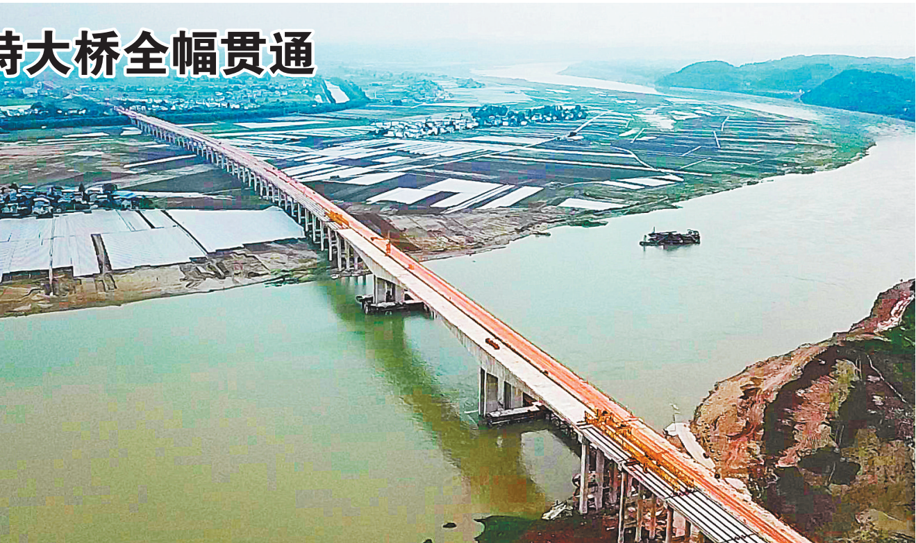
10月7日，合安高速公路涪江特大桥实现全幅贯通。
