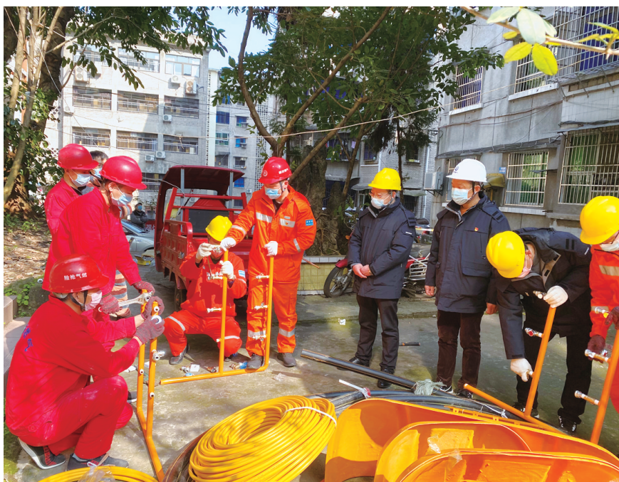
疫情防控关键期,忠县燃气公司党支部成立抗疫保供党员先锋队,为县老移民局宿舍楼安装气表架,恢复供气。
