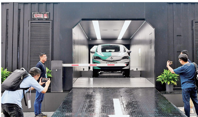
吉利智能换电站。
